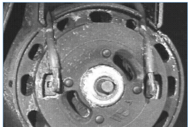
Abb. 2 Kabel, Kontakte und Isolierungen sind regelrecht zerfressen
